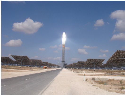
Fig1.Planta Solar de alta temperatura. TERMOSSOLAR, España
