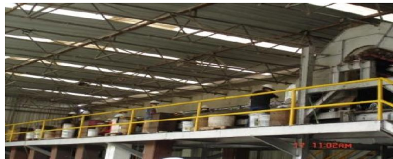
Fig. 3. Proceso de separación manual de RSU en el relleno sanitario del Municipio de Puebla (foto: cortesía concesionaria RESA).
