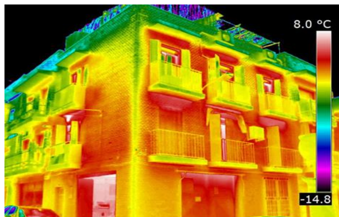
Fig. 2. Las áreas más claras de este edificio con calefacción aumentaron las pérdidas de calor. Tales indicaciones son normales para las ventanas y las puertas, las superficies irregulares de las paredes sugieren aislamiento, probablemente estaba mal colocado un material fundido en la cavidad de la pared después de la construcción. (Mur, 2011)
